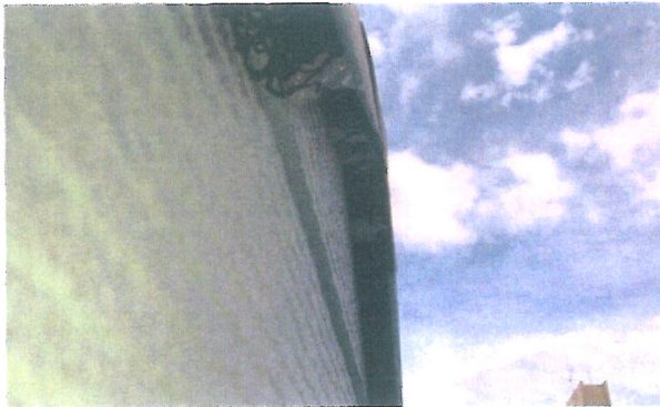
破風板上部を閉塞
