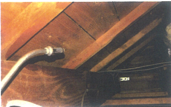
薬剤をハンドスプレーヤーで散布処理
